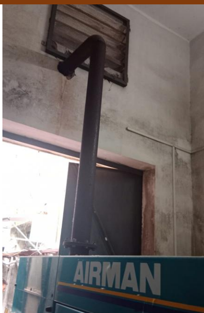
Hình 17: Hình ảnh vị trí ống khí thải của máy phát điện dự phòng
