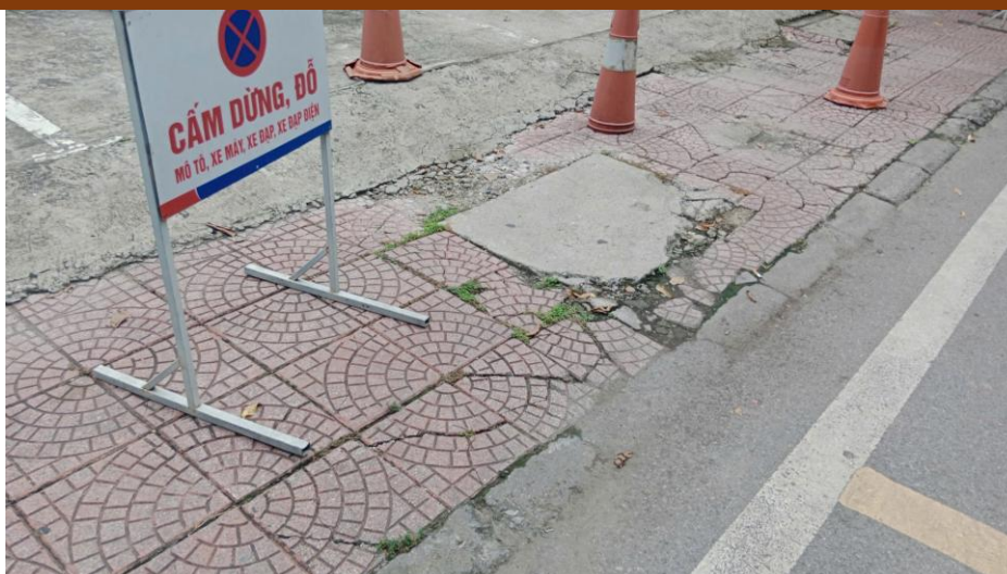
Hình 3: Vị trí hố ga thoát nước mưa cuối cùng ra hệ thống thoát nước khu vực.
